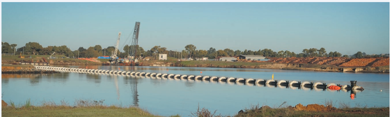
340 metre diffuser pipe.
